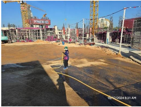
รูปที่ 13 พรมน้ำบริเวณพื้นที่ก่อสร้าง
