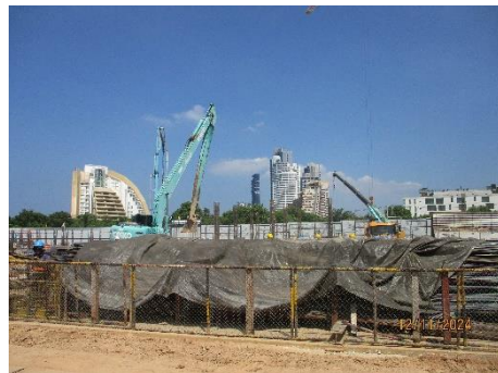
รูปที่ 7 ผ้าใบปิดคลุมวัสดุก่อสร้าง
