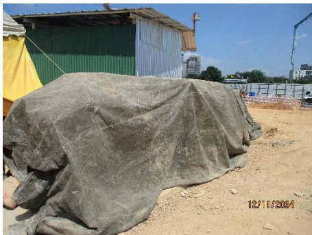
รูปที่ 7 ผ้าใบปิดคลุมวัสดุก่อสร้าง
