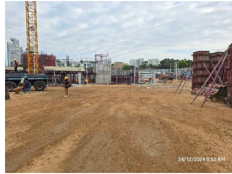
รูปที่ 13 พรมน้ำบริเวณพื้นที่ก่อสร้าง
